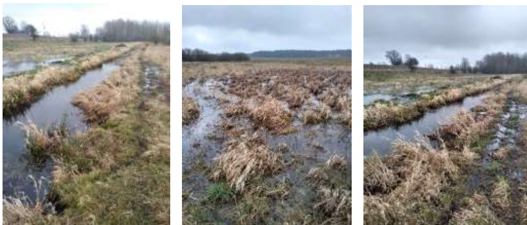
Gminna Spółka Wodna Szczecinek – Dałęcino zdjęcia wykonane w dniu 20 sierpnia 2020 r. – końcowy odbiór prac
